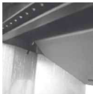
Fig. 15: soulever la plaque coupe-flamme
