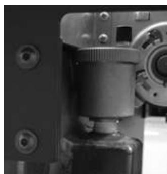
**Valve de ventilation automatique:** cette valve permet d'éliminer l'air à l'intérieur de l'hydropoêle et de système de chauffage.
