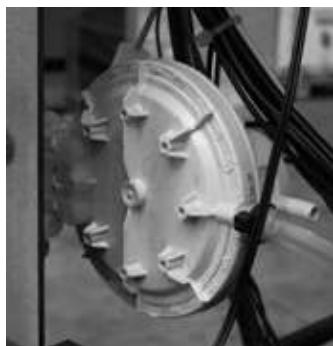
**Presostato:** controla la presión del conducto de humos. Se ocupa de bloquear la cóclea de carga de las pellas en caso de que la descarga esté obstruida o de que haya contrapresiones significativas por ejemplo en presencia de viento. En el momento del interruptor de presión va a leer "**ALAR-DEP-FAIL**".
