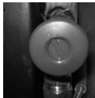
**Válvula de seguridad:** esta válvula actúa para evitar la sobre presurización del sistema hidráulico. Si la presión del calentador o de la planta excede de 2,5 bar se drena el agua del circuito.
