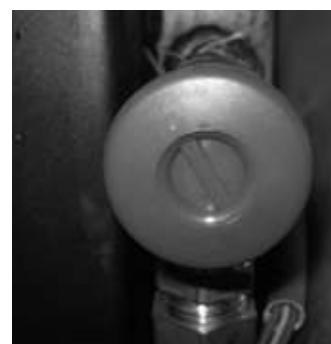
**Valve de sécurité:** cette vanne agit pour empêcher une surpression du système hydraulique. Si la pression de l'hydropoêle ou le système est supérieure à 2,5 bar, il draîne l'eau du circuit.
