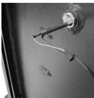
**Sonde de température eau:** si la température de l'eau s'approche de la température de blocage (100°C), la sonde impose à arrêter l'alimentation des granulés de bois.
