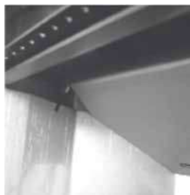
Fig. 15: soulever la plaque coupe-flamme
