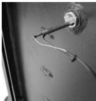
**Sonda de temperatura agua:** si la temperatura del agua se aproxima a la temperatura de bloqueo (100°C) a sonda impone para detener la alimentación de los pellets.
