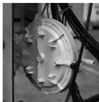
**Interruptor de presión de humo:** controla la presión en el conducto de humo. Bloquea el sifón de carga de pellets en caso de que el drenaje esté bloqueado o haya contrapresiones significativas, por ejemplo, en presencia de viento, puerta de la cámara de combustión abierta o falla del extractor de humos. Cuando se active el interruptor de presión, aparecerá la palabra "**ALAR-DEP-FAIL**".
