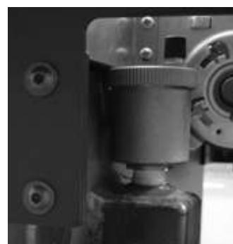
**Válvula de ventilación automática:** esta válvula elimina el aire dentro de la caldera de calefacción y de la calefacción
