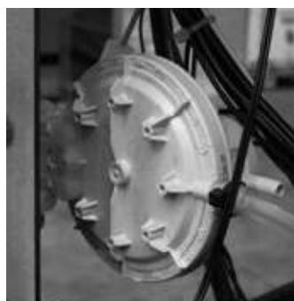
**Interrupteur de pression de fumée:** contrôle la pression dans le conduit de fumée. Il bloque la vis de chargement des pellets en cas de blocage du drain ou de contre-pressions importantes, par exemple en présence de vent, d'une porte ouverte de la chambre de combustion ou d'une défaillance d'extracteur de fumée. Lorsque le pressostat est activé, l'écrite "ALAR-DEP-FAIL" apparaîtra.
