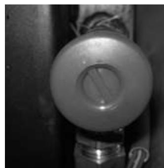
**Valve de sécurité:** cette vanne agit pour empêcher une surpression du système hydraulique. Si la pression de la Chaudière ou le système est supérieure à 2,5 bar, il draine l'eau du circuit.
