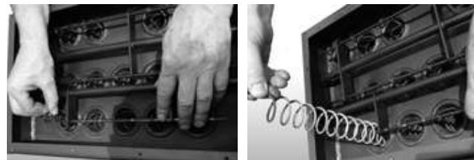
Para ello, el pasador horizontal se puede extraer a través de un agujero en la pared del cuerpo de la Caldera.
