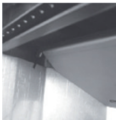
Εικ. 15: ανύψωση του διαχωριστικού φλόγας
